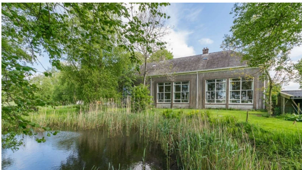
Figuur 3: Aanzicht zuidzijde voormalig schoolgebouw Ulesprong 18 Tijnje
