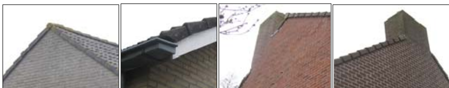
Dakranden in het plangebied met voor vleermuizen toegankelijke kantpannen
