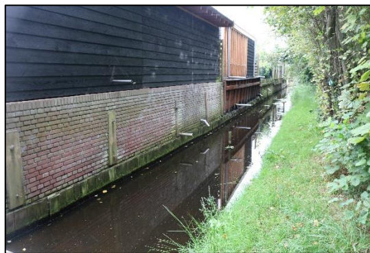
Afbeelding 2.17. Beschoeiing zuidelijke watergang.
