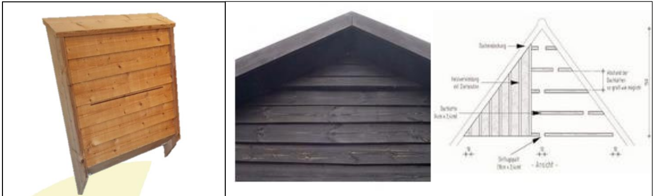
Figuur 20. Aan de schuur zal een externe vleermuiskast (Faunus FVM03) worden geplaatst of wordt gebruik gemaakt van voor vleermuizen geschikte gevelbetimmering
