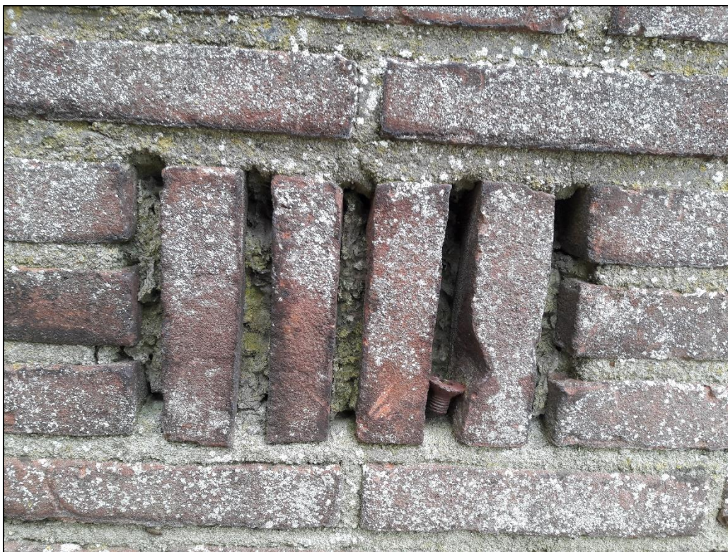
Figuur 10. Het woonhuis kent een geïsoleerde spouwmuur, de dakconstructie van het woonhuis is wel geschikt voor vleermuizen
