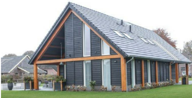
Schuurwoning (Bron: www.woodteq.nl/project/schuurwoning )
