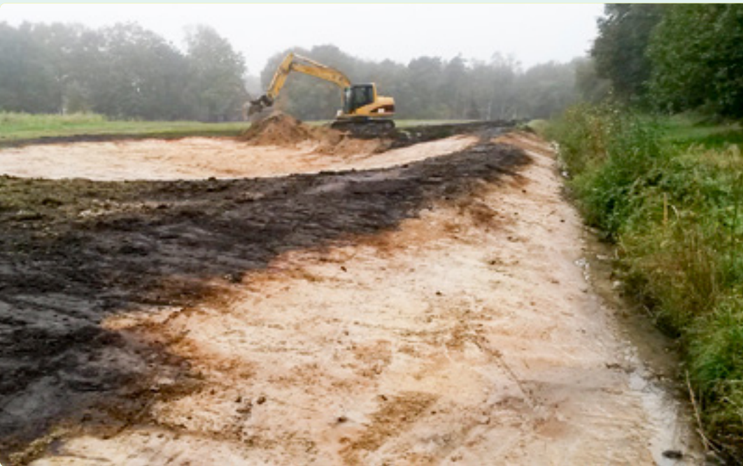
Aanleg poel Hoge Hexel
