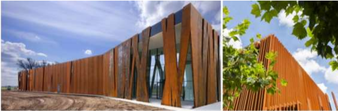
Afbeelding 2. Cortenstaal met verticaal karakter. Sterk Gorredijk, Sluijmer en van Leeuwen architecten (links) en DMOA (rechts)
