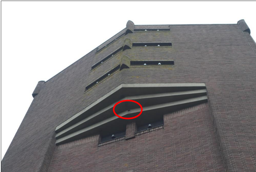
Potentiële invliegopening voor gierzwaluw en vleermuizen
