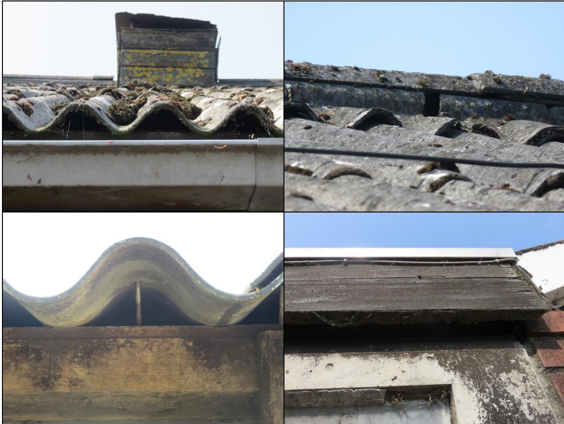
Figuur 2.4. Ruimten en kieren binnen het plangebied die mogelijk toegangen tot verblijfplaatsen van vleermuizen vormen.
