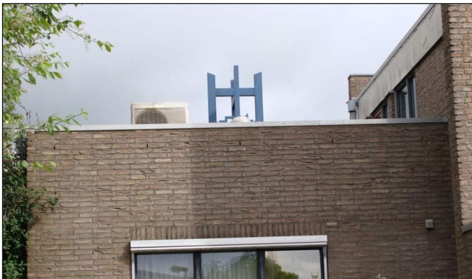
Figuur 6. Stootvoegen aan de achterkant van het pand van de voormalig Frieslandbank (in dit geval de zuidoost zijde).
