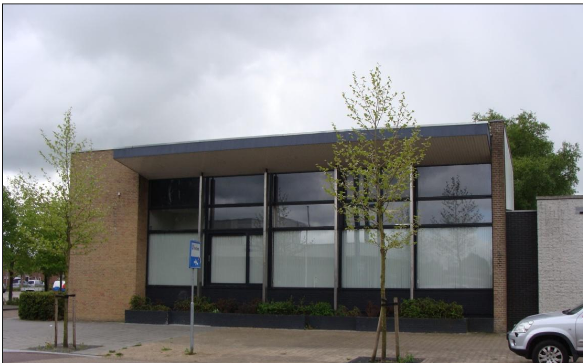
Figuur 3. Voormalig Frieslandbank aan de zijde van de Schansburg.
