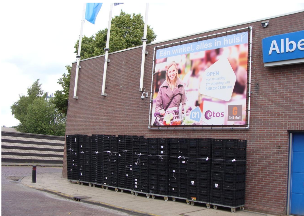
Figuur 3. Koelcel en magazijn van het Albert Heijn filiaal (aan de Lijnbaan zijde)
