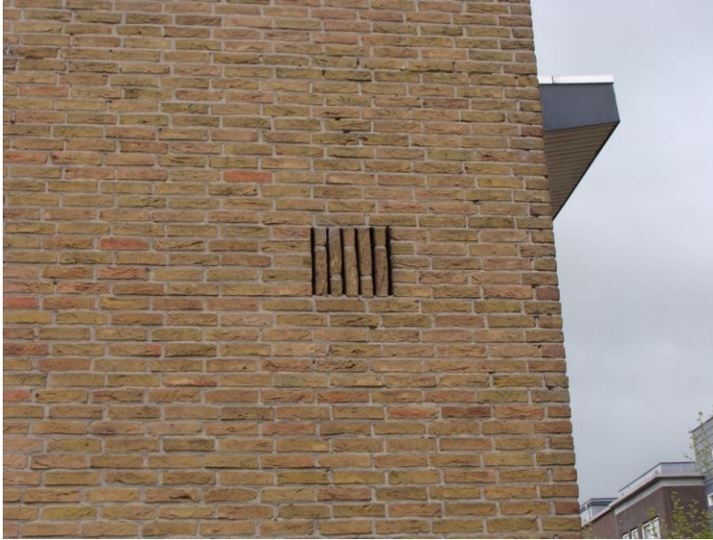
Figuur 5. Open voegen aan de voorzijde van het pand (rechter blok aan zijde Hofland).
