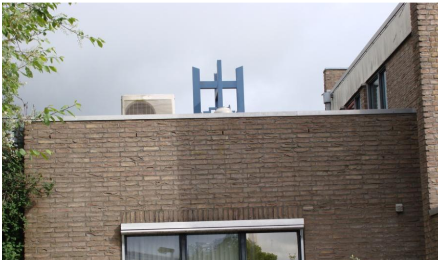
Figuur 6. Stootvoegen aan de achterkant van het pand (in dit geval de zuidoost zijde).
