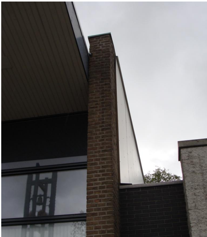
Figuur 9. Plaatbedekking aan de zuidwestzijde van het gebouw.
