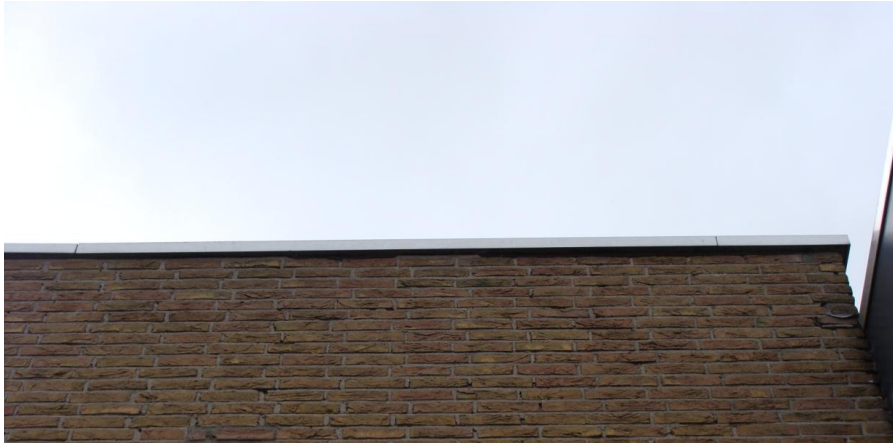
Figuur 8. Beschadigd metselwerk aan de zijde van de Schansbrug.
