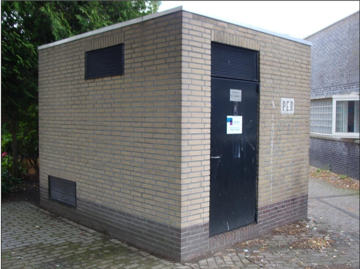
Figuur 12. Elektriciteitshuisje achter de Hoofdstraat 13 te Gorredijk.
