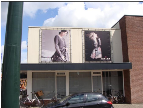
Figuur 10. Lijnbaan 7/7a gezien van de Lijnbaan (lage gedeelte van het pand).
