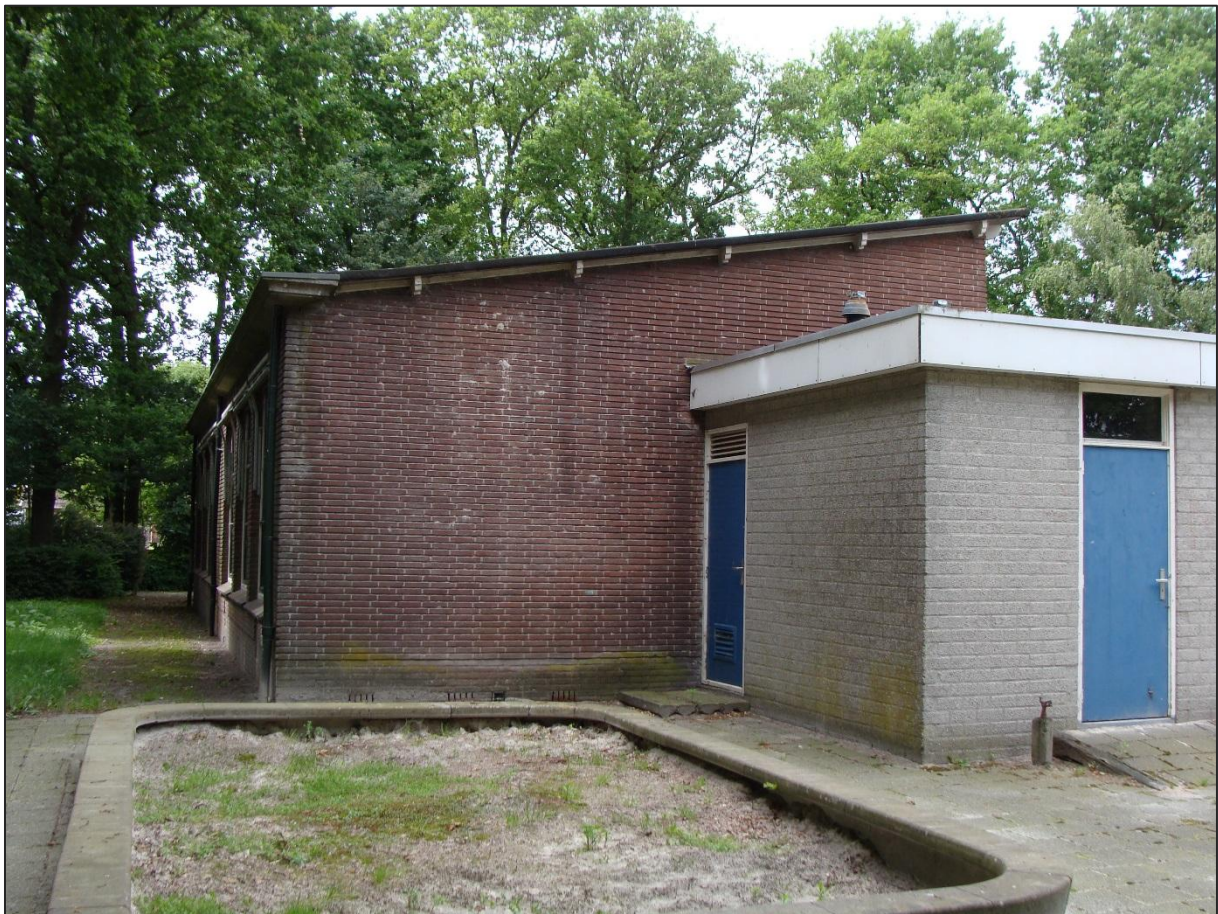
Figuur 2. Impressie van het voormalig schoolgebouw.
