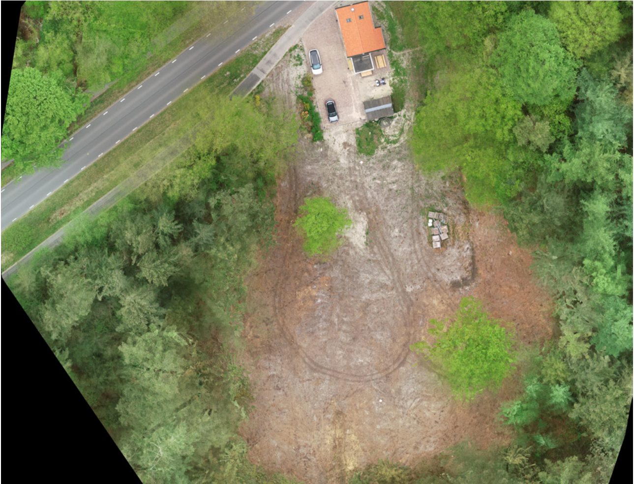
Luchtfoto huidige situatie
