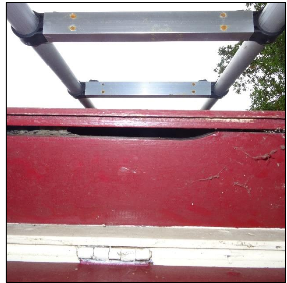
Afbeelding 3.6. Toegangsweg tot achter boeiboord (kantine).
