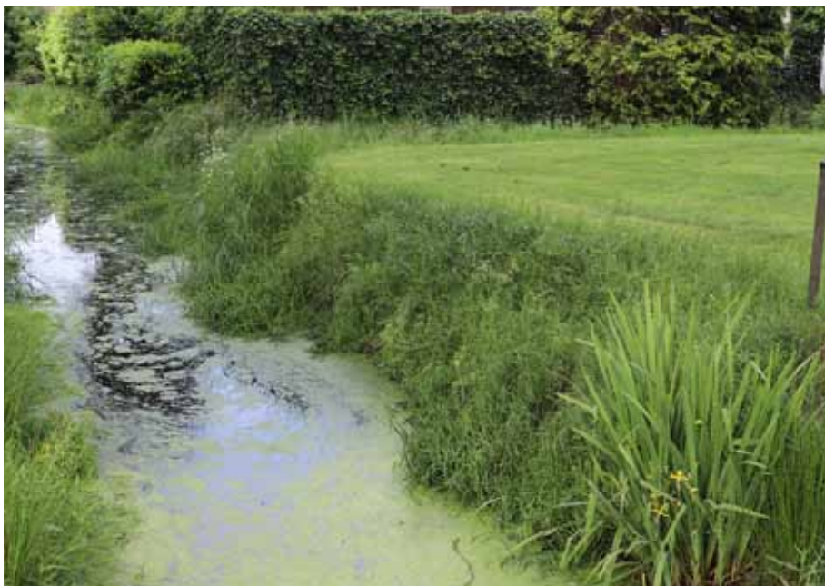
B8. Aan de noordwestzijde van het plangebied is de sloot langs de Vlaslaan een stuk breder en duidelijk watervoerend.
