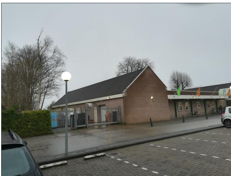
Figuur 2. Impressie van het plangebied vanaf de noordzijde, links de opslagruimte en houtwal waar het pand wordt uitgebreid, rechts de terugvallende gevel die naar voren wordt geplaatst (19 december 2017).
