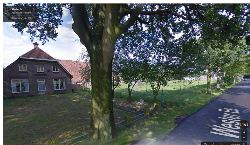
Afbeelding 1: Plangebied met boven een luchtfot van het plangebied (bron: Bing Maps) en onder de af te breken bedrijfsbebouwing (bron: Street View Google Maps).
