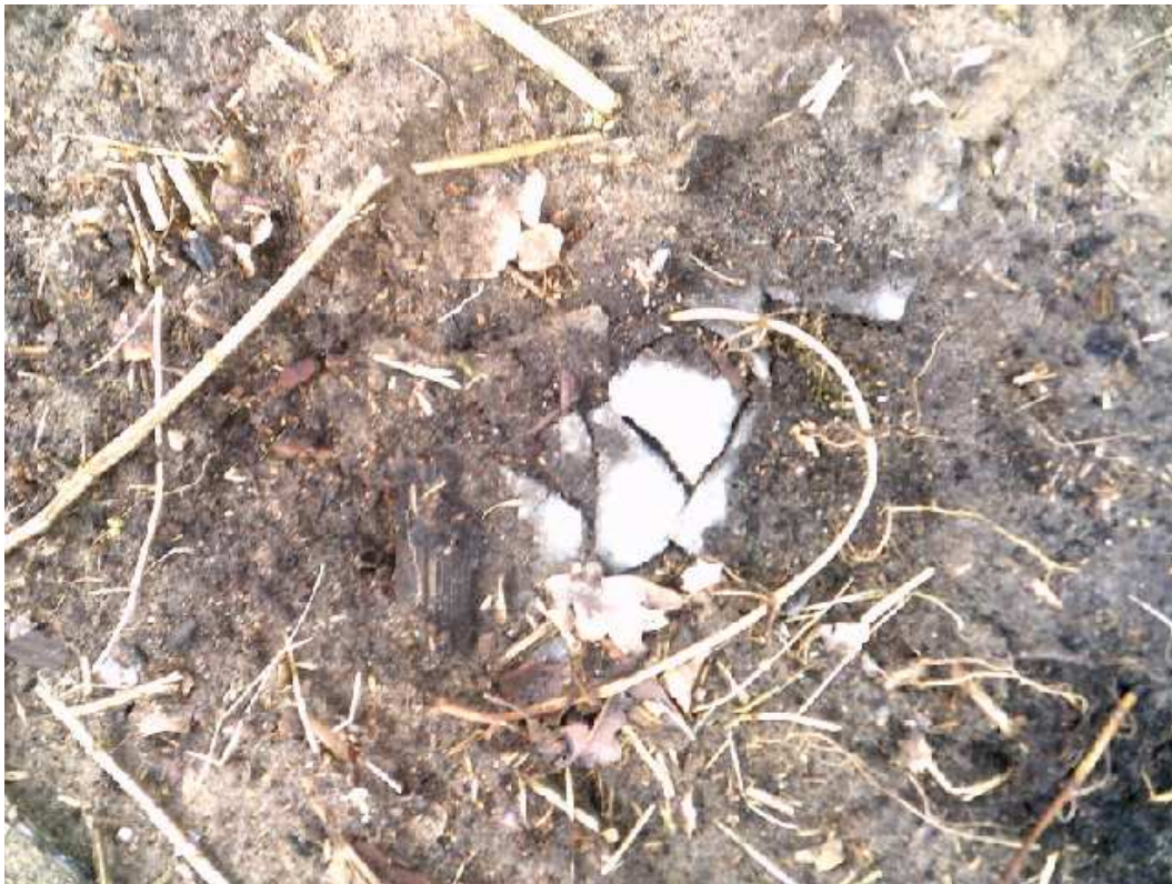
Foto 12. Wester Es 48, Appelscha asbestverdachte materiaal op maaiveld
