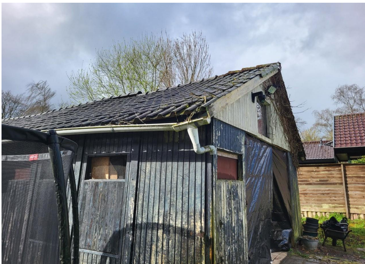
(0.4 Achterzijde (bestaande) schuur)
