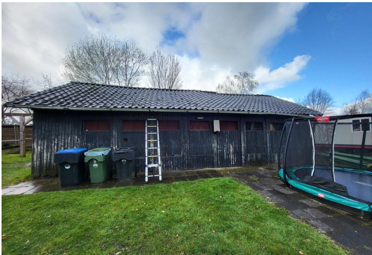
( 0.2 Rechterzijde (bestaande) schuur met het pannendak)
