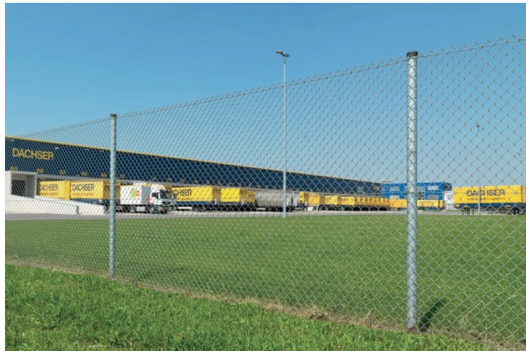
Hekwerk: gaashekwerk Heras 'Orses' 2 m hoog.
