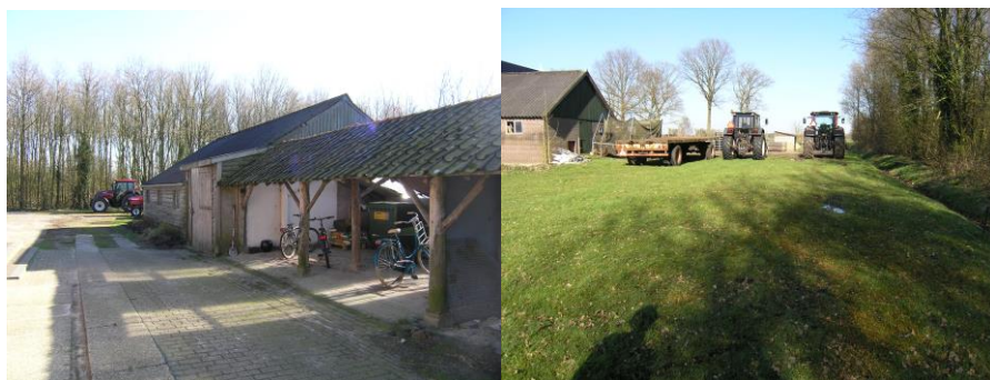
Impressie projectgebied: links te slopen schuren en rechts locatie nieuwe schuur (22 maart 2017)
