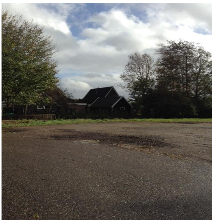
Foto 3: met halfverharding verharde deel van de parkeerplaats
