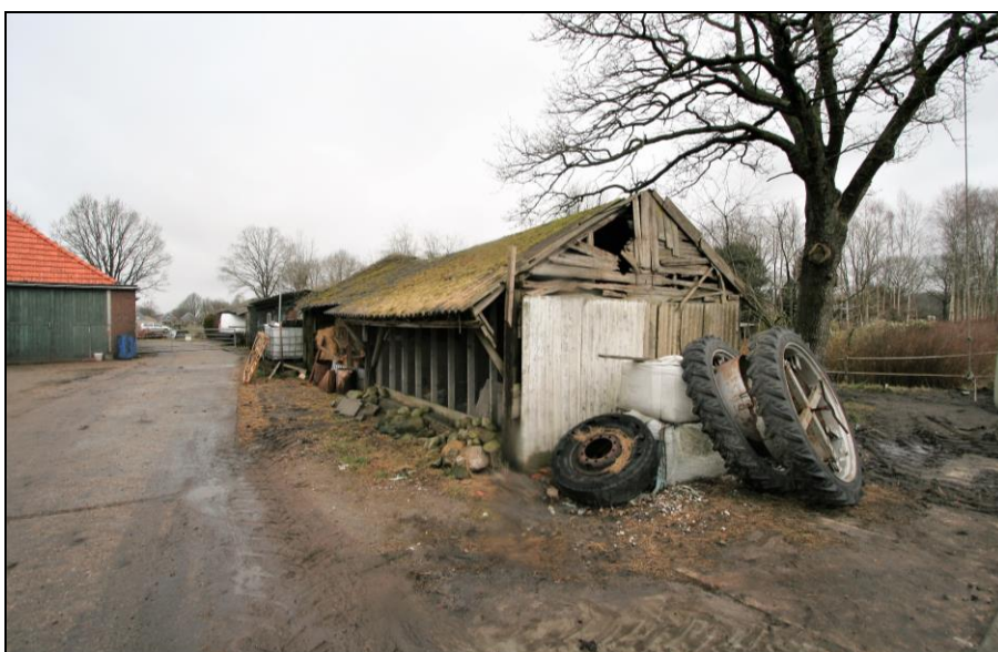
Te slopen schuren aan de oostzijde
