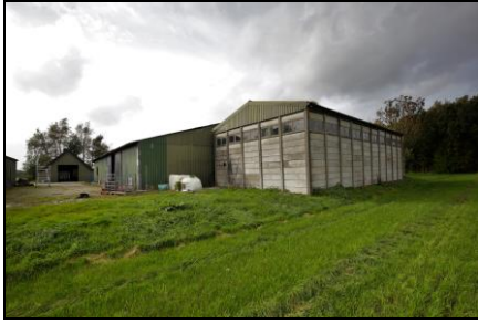
Te slopen schuren aan de oostzijde
