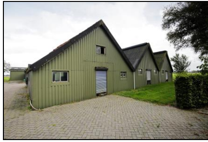
Te slopen schuren aan de westzijde
