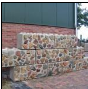
Figuur 2: legosteent afgewerkt met natuursteen.
