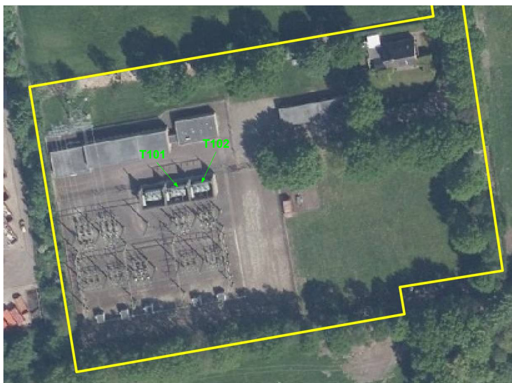
f2.2 Overzicht transformatoren huidige situatie
