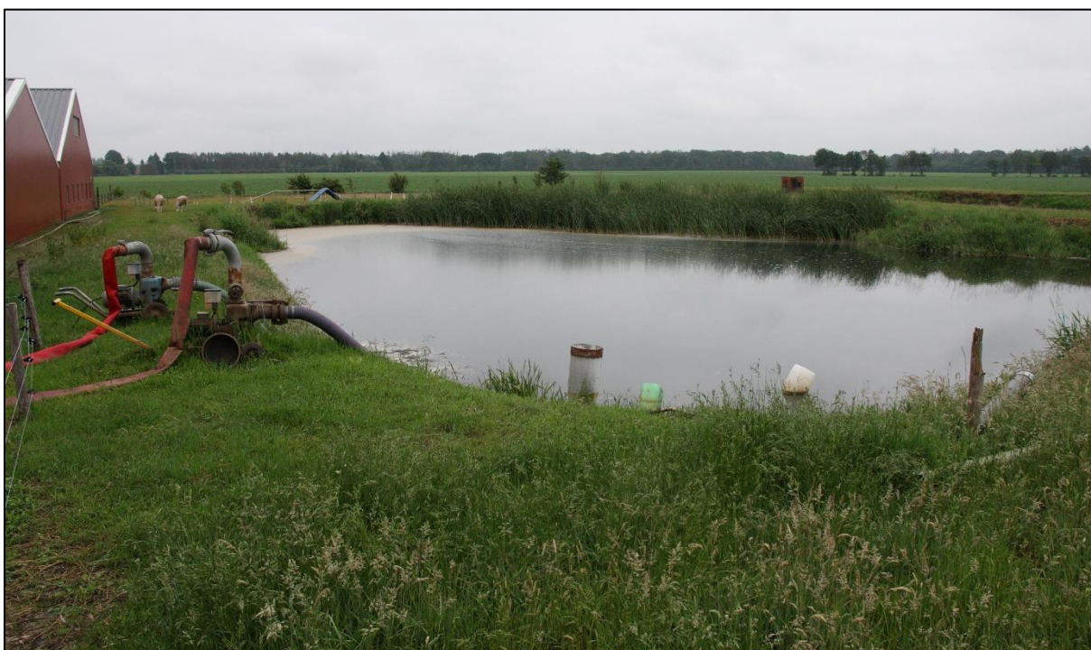
Figuur 6. Uitgegraven vijver annex bezinkbassin binnen het plangebied
