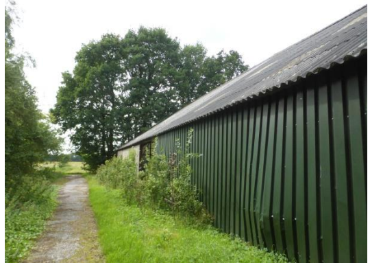
Pad ten zuiden van kapschuur
