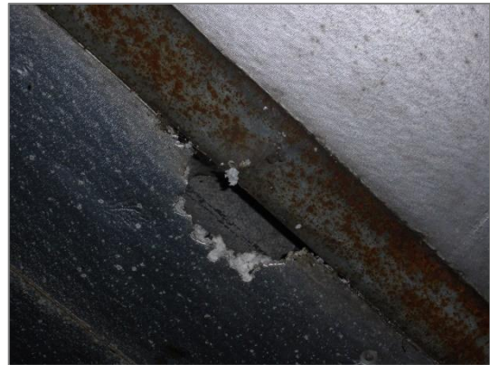
Figuur 4.2. knaagsporen dakisolatie aardappelloods
