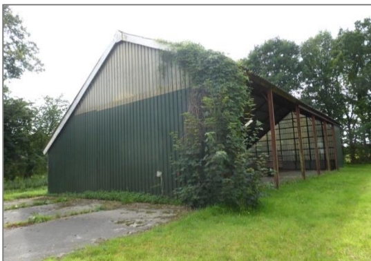
Figuur 2.3. Aanzicht kapschuur vanuit het oosten
