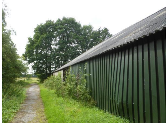
Pad ten zuiden van kapschuur
