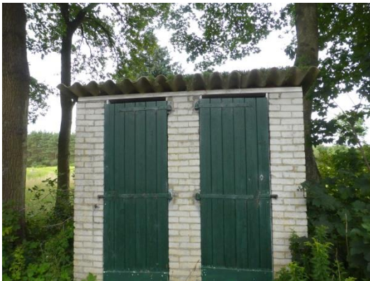
Aanzicht klein toiletgebouw vanuit zuiden
