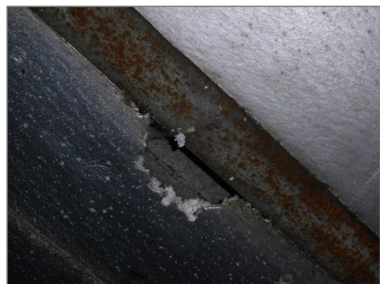
Figuur 4.4. knaagsporen d'isolatie aardappelloods
