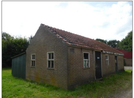
Aanzicht bijgebouw vanuit het noordoosten
