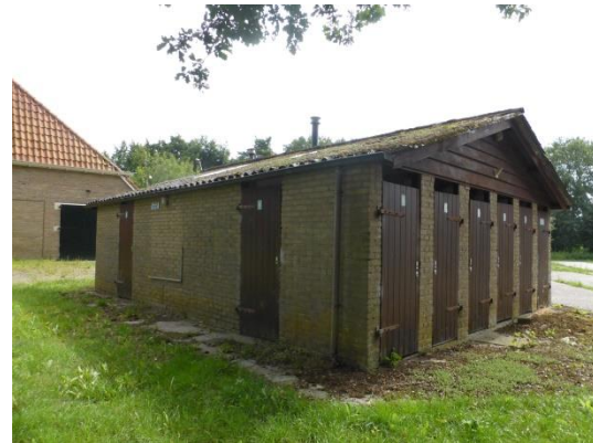
Aanzicht groot toiletgebouw vanuit noordwesten
