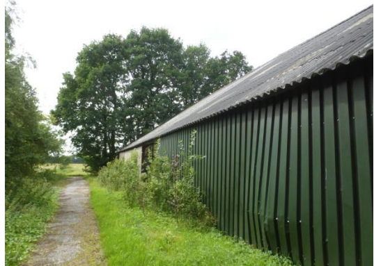
Pad ten zuiden van kapschuur
