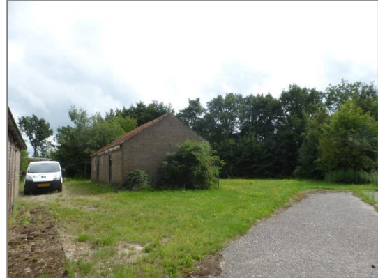
Figuur 4.2. terrein naast bijgebouw en toiletgebouw
