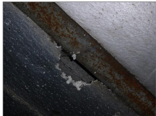
Figuur 4.4. knaagsporen d'isolatie aardappelloods
