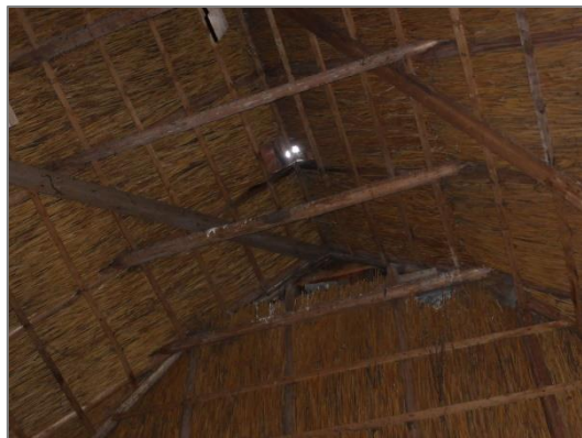
Dak van schuur aan woning
