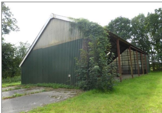
Figuur 2.3. Aanzicht kapschuur vanuit het oosten
