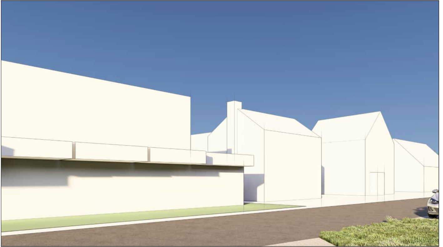
standpunt voorzijde 21 sep 2025 - 9 uur bestaand situatie
