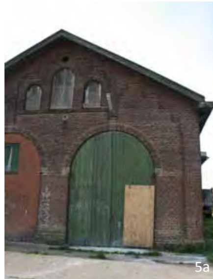
Spoorloods zijde rangeerterrein
