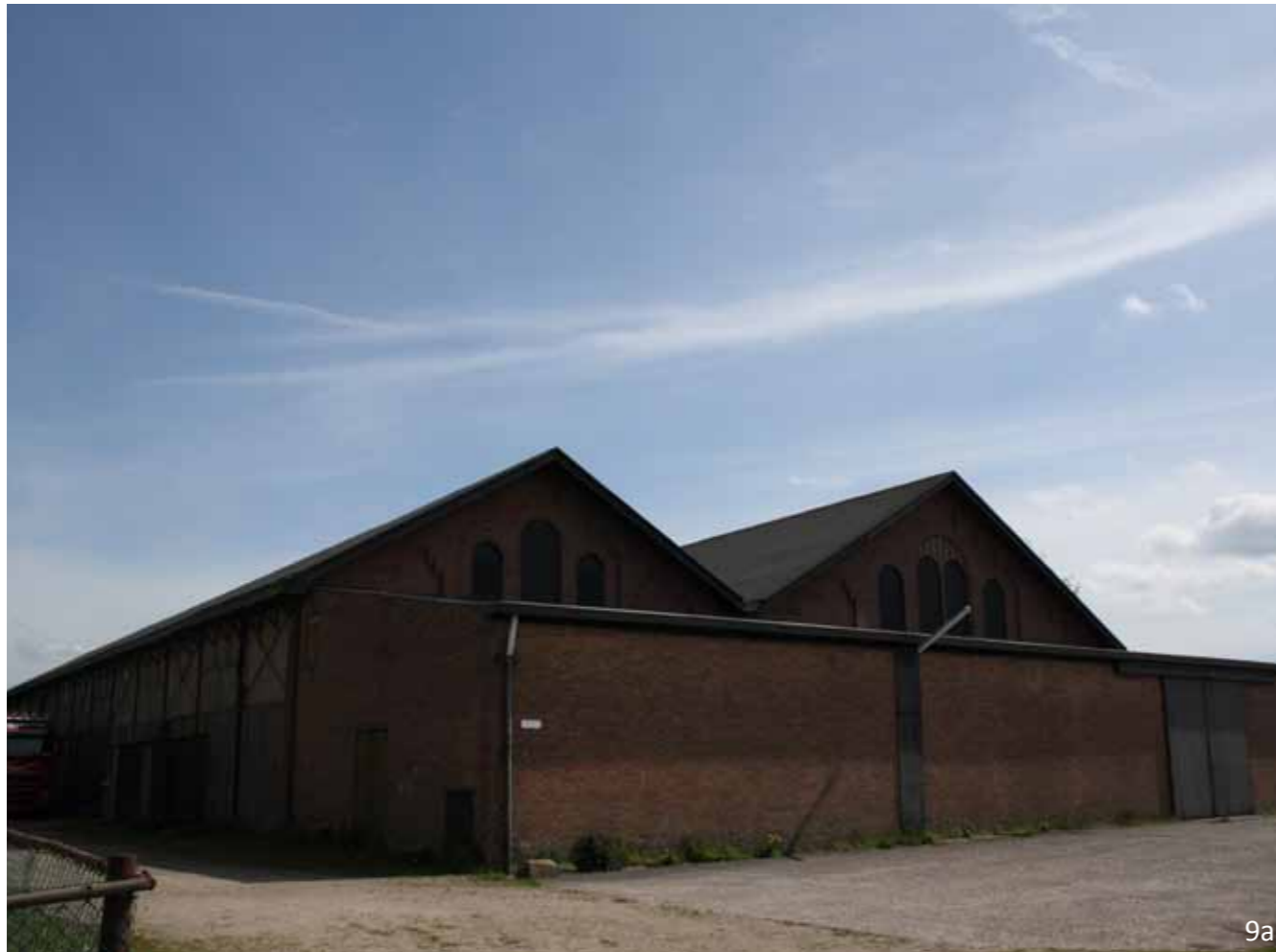
De aanbouw aan de straatzijde dient te worden verwijderd
