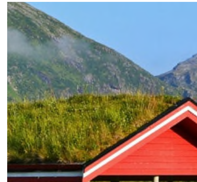
De schuur in de tuin krijgt een hellend sedum of grasdak
