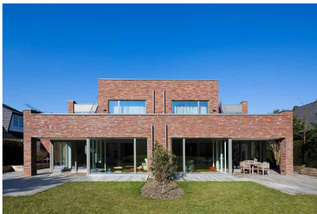
tweekapper in roodbruin metselwerk
