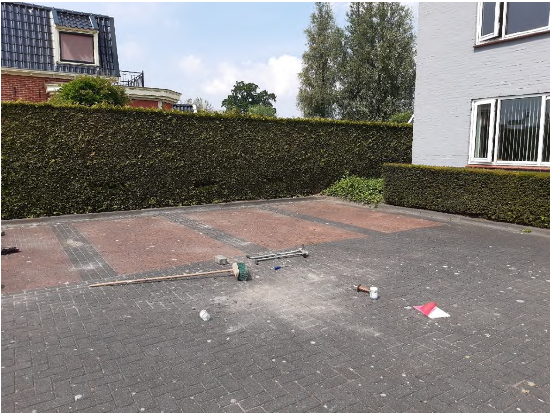
Boring 1 en boring 5
