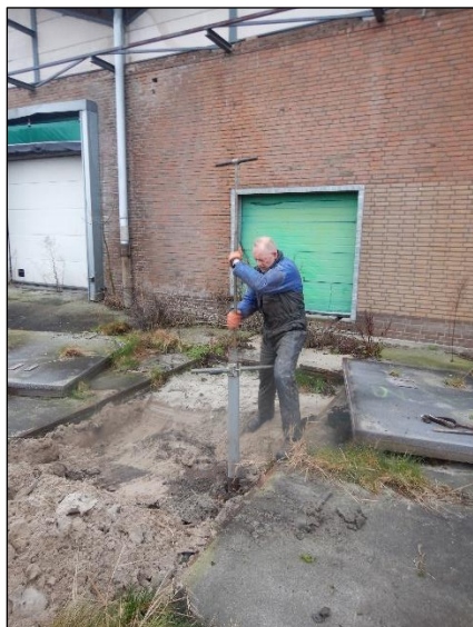
Afbeelding 24. Het boren door de verbuizing. De fotorichting is richting het oosten genomen
