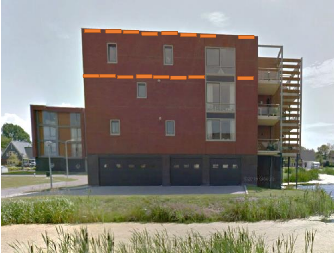
Twee rijen met acht (triple)kasten op de kopgevels.
