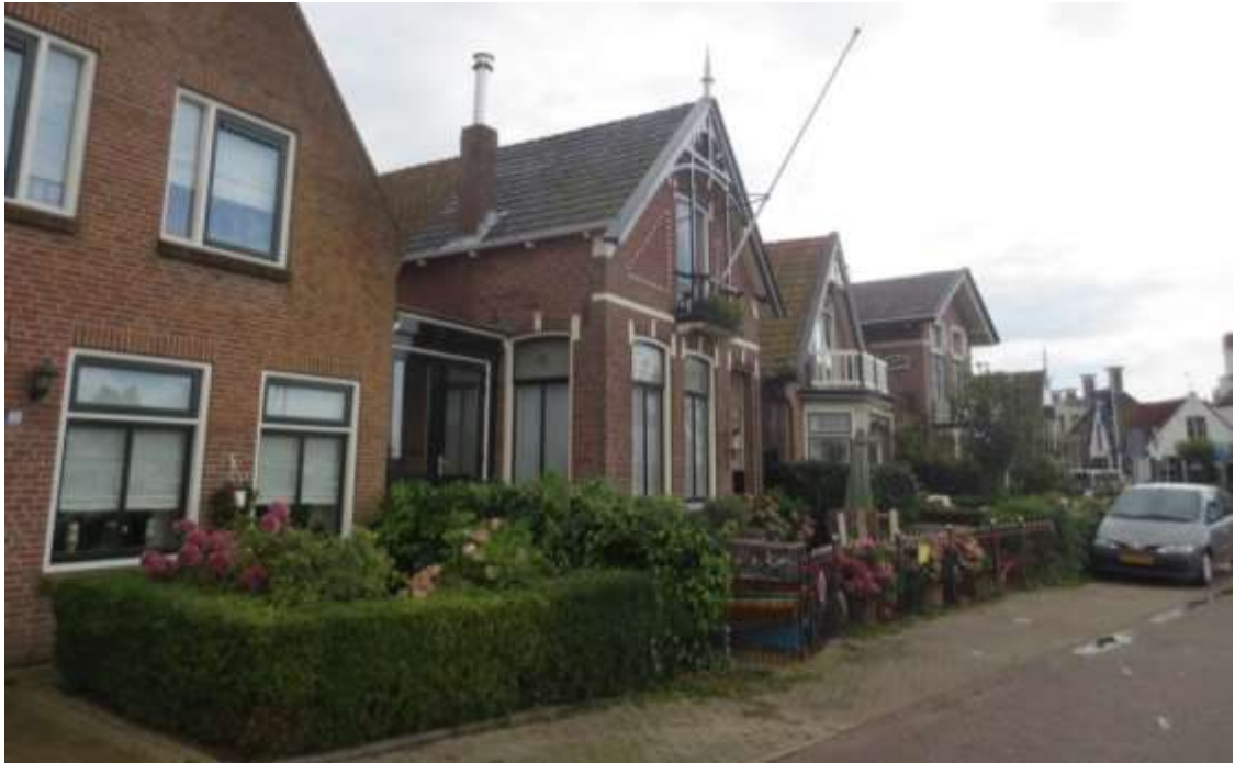
Rijk versierde daklijsten. Speklagen en ramen “om de hoek” voor overhoekse zichtlijnen
