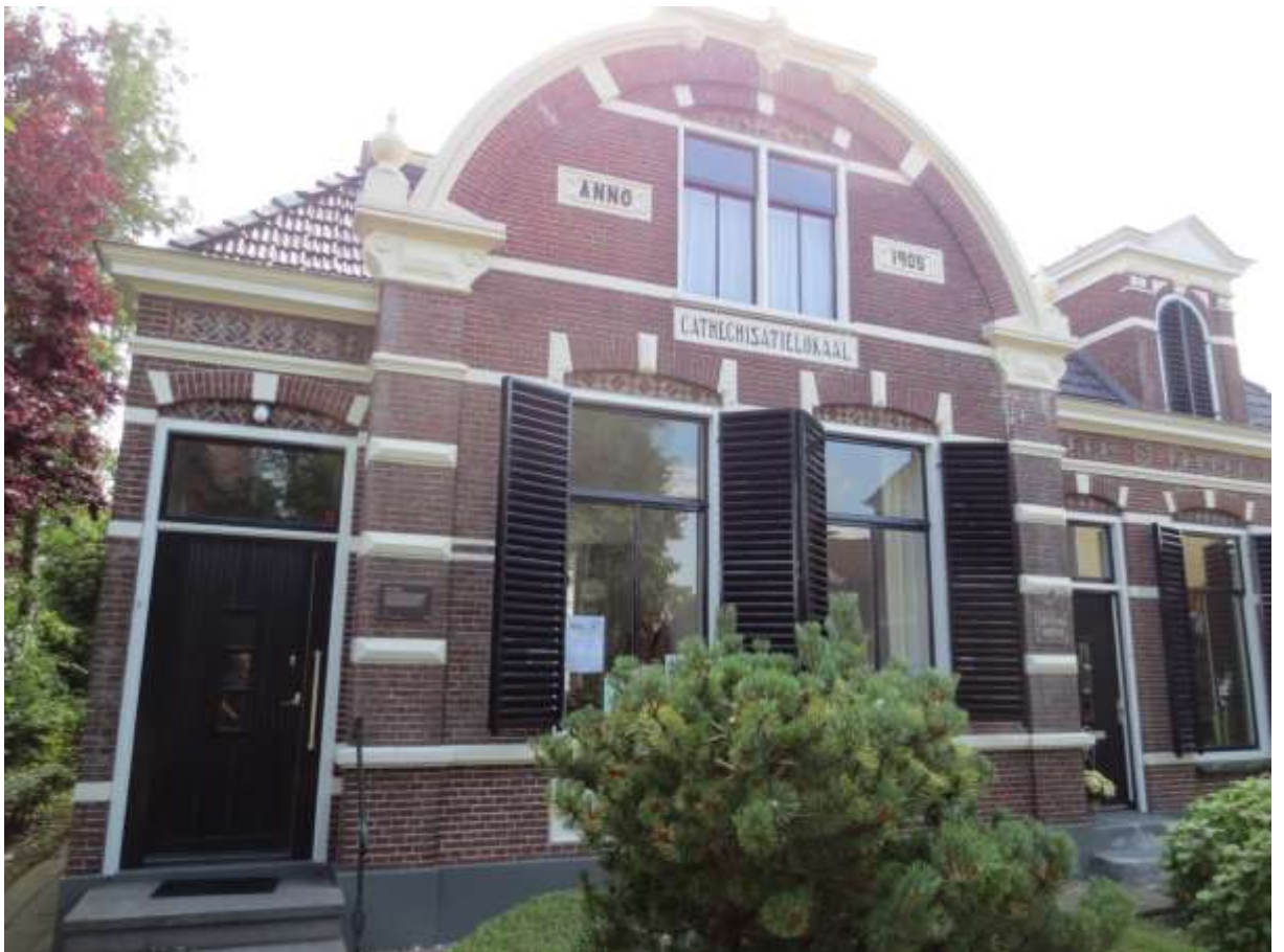
Cathechisatielokaal. Metselwerk met horizontale speklagen. Hoge ramen en hoge entreedeur met bovenlicht. Rijk, met stuc- en tegelwerk, versierde gebogen rollagen boven ramen en deur. Groot uitgebouwde eerste verdieping en groot dakkapel in de goot.
