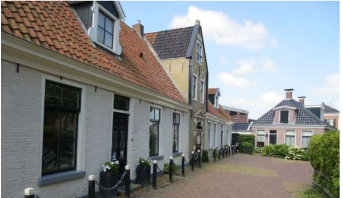
Langs- en dwarskappen die elkaar afwisselen. Twee- en drielaagse woningen.
