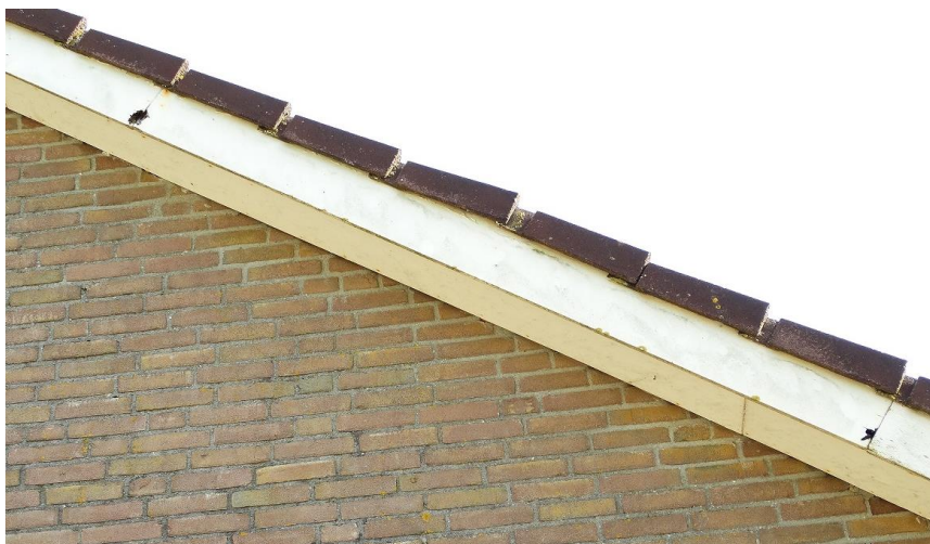
Figuur 5-7. Bovenaan de nok is er een spleet in het dakbeschot zichtbaar. (Foto: M. Zweemer).
