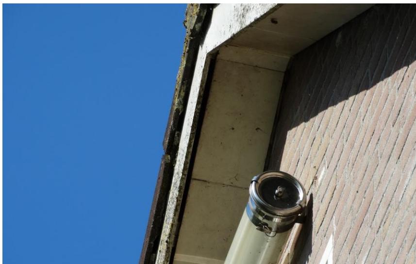
Figuur 5-7. Bovenaan de nok is er een spleet in het dakbeschot zichtbaar. (Foto: M. Zweemer).
