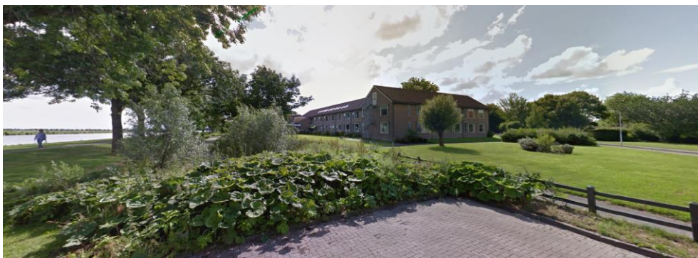
Figuur 3. Aanzicht huidige situatie (bron: Google Streetview)
