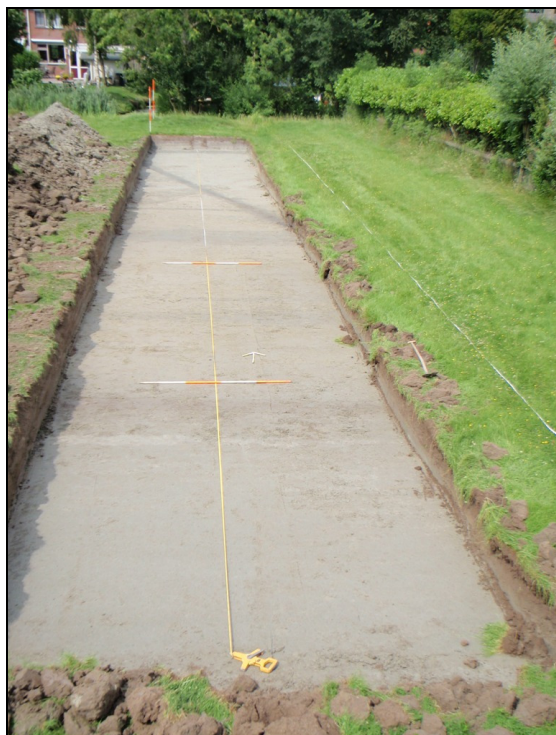
Afbeelding 15. Beeld van werkput 2, in noordelijke richting
