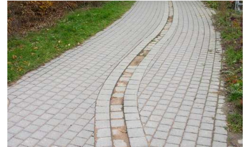
Oppervlakkige, zichtbare afwatering op oppervlaktewater
