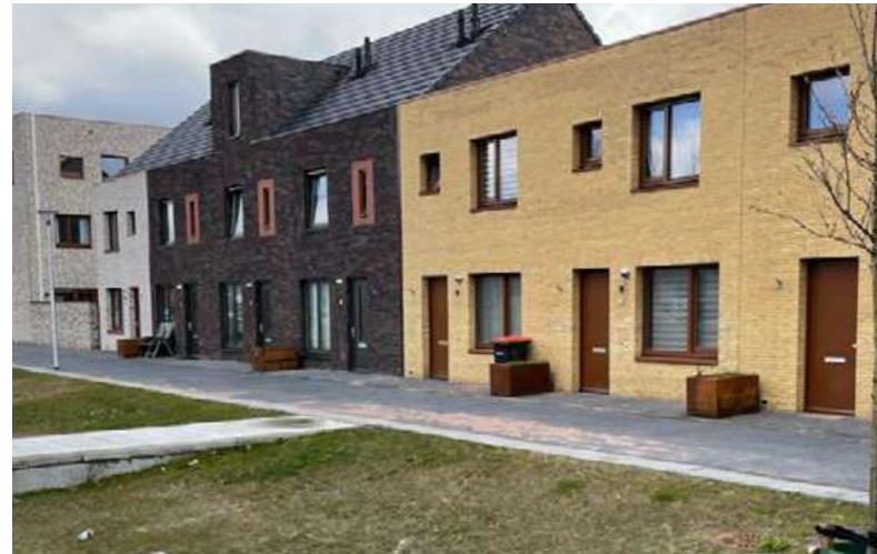
Eenheid in gevelopbouw, afwisseling in kleur
