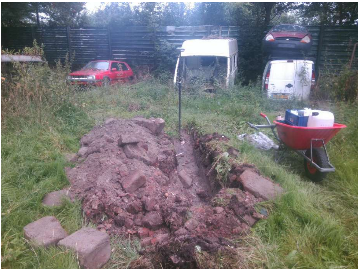
Foto van ontgraven materiaal ter plaatse van sleuf SL03b
