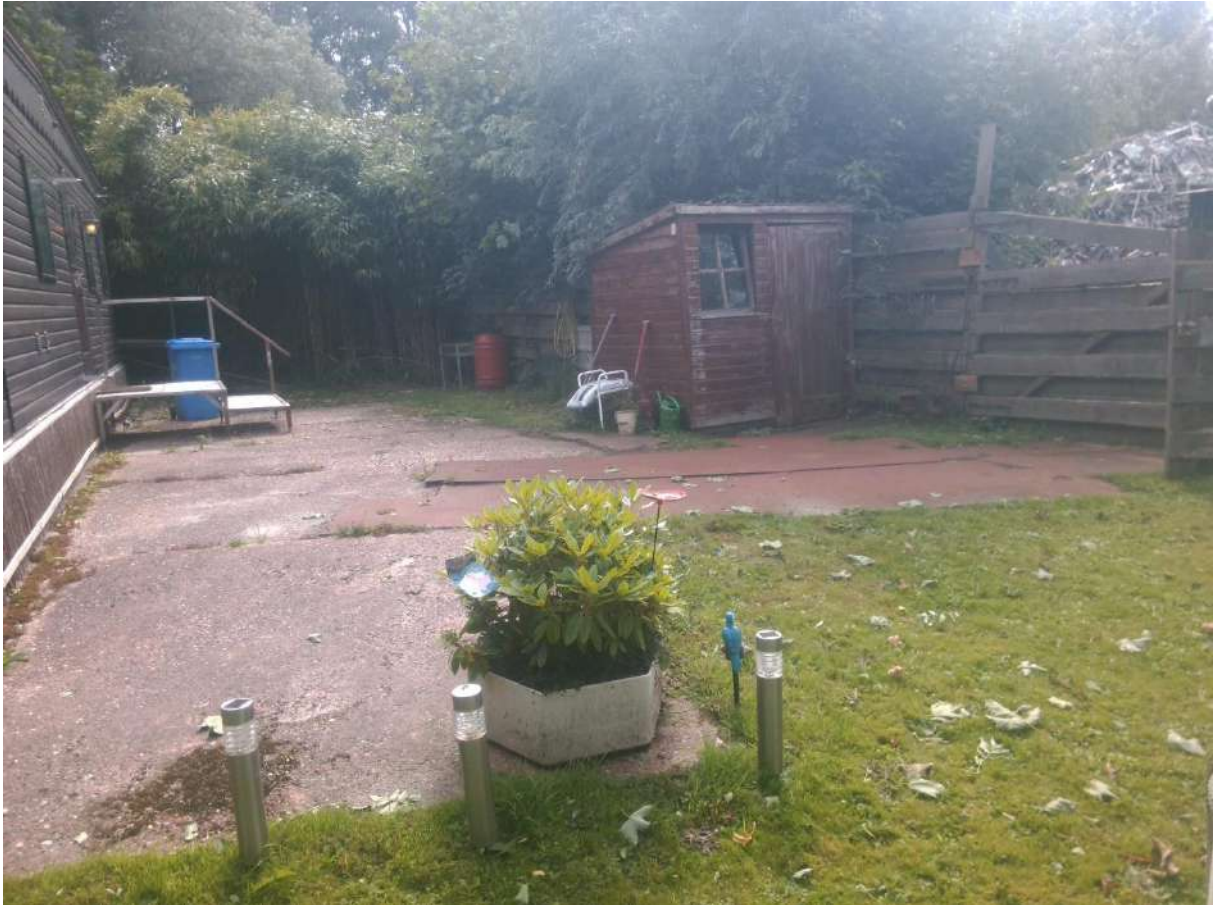
Foto ter plaatse van het noordelijk terreindeel (chalet en naastliggende betonverharding en grasveld)
