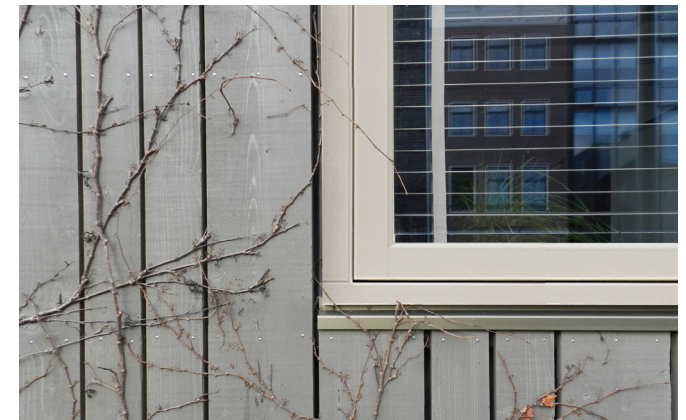
Referentie, gevelbekleding is uitgelijnd op kozijn
