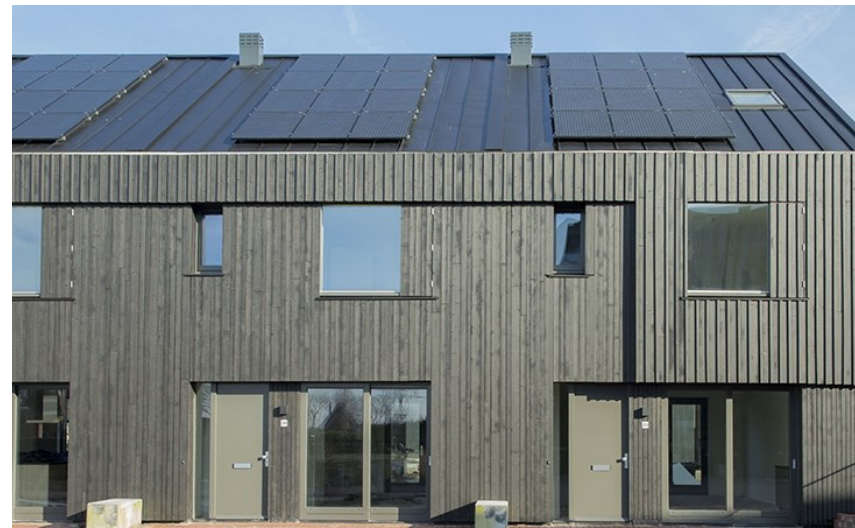
Referentie, kozijnen in de zelfde tint als de gevel, verschillende soorten gevelbekleding en negges
