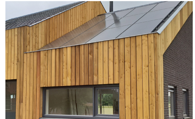
Referentie, houten gevelbekleding en ondergeschikt baksteen
