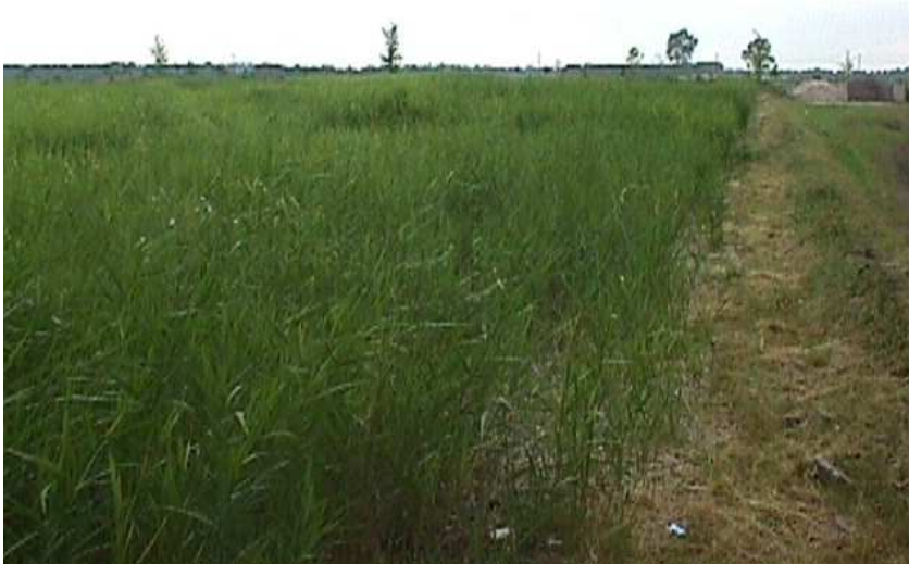
Figuur 5; helofytenfilter met riet (bron: Royal Haskoning)
