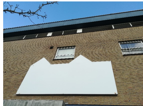
Foto 10: Raamkozijn 'in- en uitvliegende dwergvleermuis 2009'
