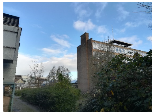
Foto 12: mogelijk verblijfplaats voor vleermuizen
