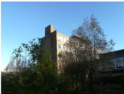
Foto 11: mogelijk verblijfplaats voor vleermuizen
