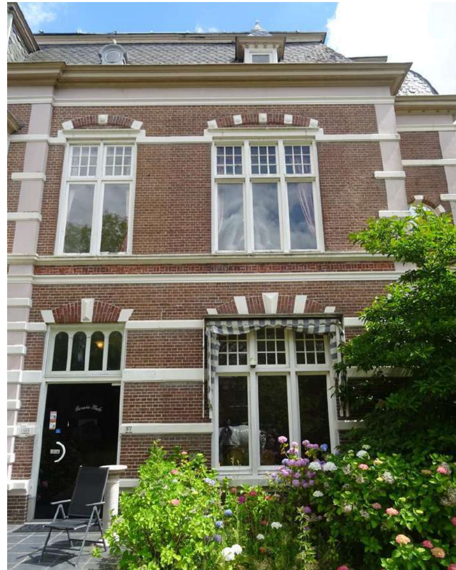
Voorgevel west, terugliggende geveldeel rechts. De twee rechters vensters zijn in 1903 ingepast. Aan de donkere baksteen is een oudere indeling nog te herkennen.
