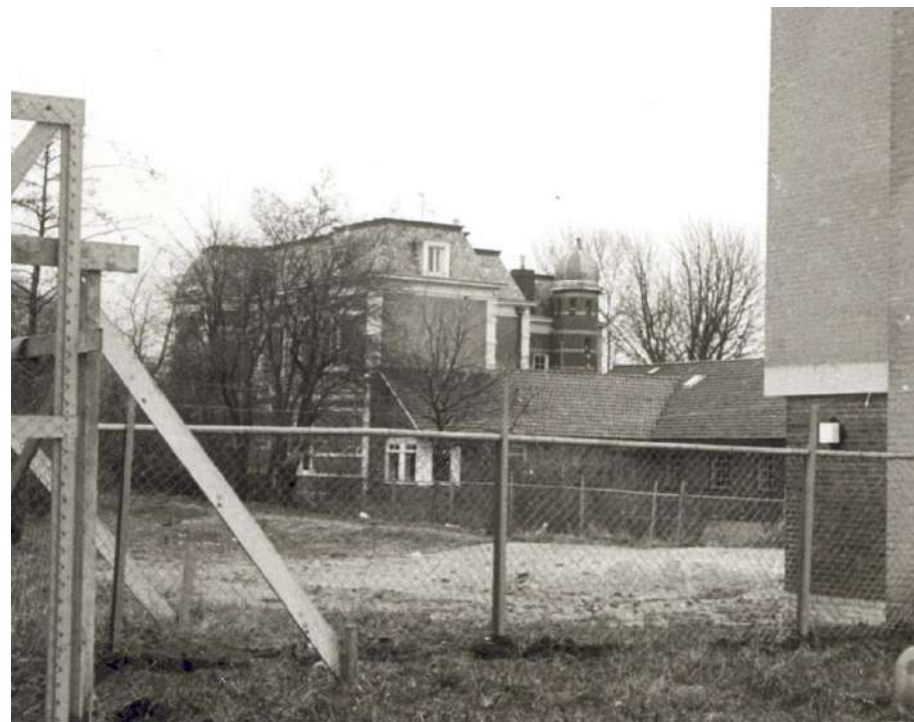
Aanzicht vanuit zuidoosten met aanbouwen uit 1933, foto 1970. Bron: HCL, FDVRLSCHB027B.
