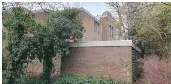
Figuur 5 en 6. Te slopen achterzijde.
