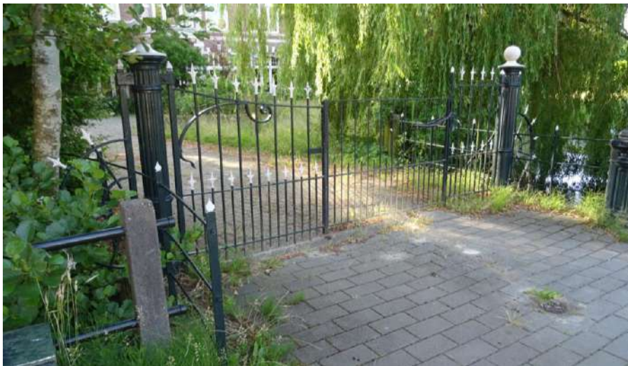
Het toegangshek in de huidige staat.
